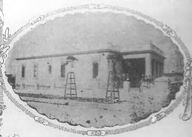
Otro aspecto de la fachada.
